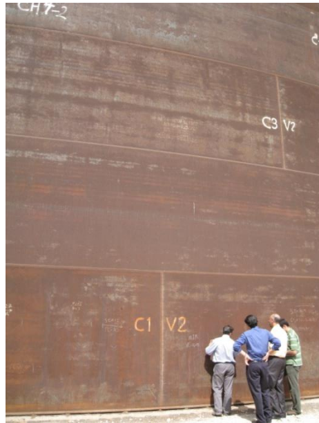
شکل ۵-۰ نمایی از پوسته مخزن که نشان دهنده ابعاد ورق‌های مخزن می باشد
