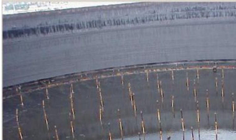
شکل ۹-۱ شناور شدن سقف مخزن و خرابی سقف (زلزله ازمیت ترکیه، ۱۹۹۹) [۱۷]
