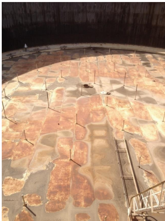
شکل ۱۵-۰۰ نمای از سقف شناور مخزن ۳۰۰۰۰۰ بشکه ای همراه با نردبان دسترسی به سقف، واقع در پالایشگاه نفت تهران
