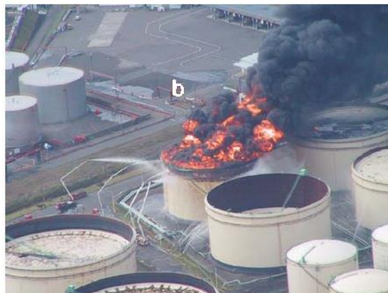
شکل ۱۱-۱۱) آتش‌سوزی کامل مخزن بنزین سنگین (سمت راست)
