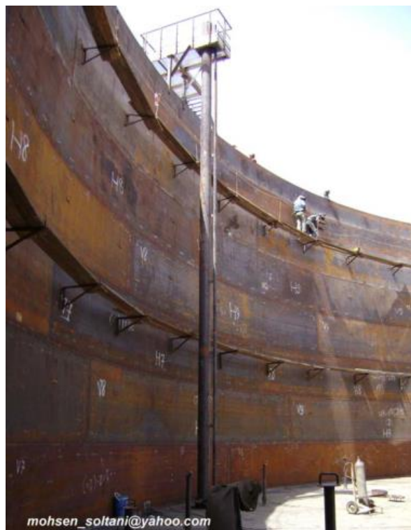
شکل ۱۴-۰ استفاده از guide pole جهت بهره برداری و نجسیدن سقف به جداره ها (محسن سلطانی، حسین زینلی، ساخت مخازن سقف شناور)
