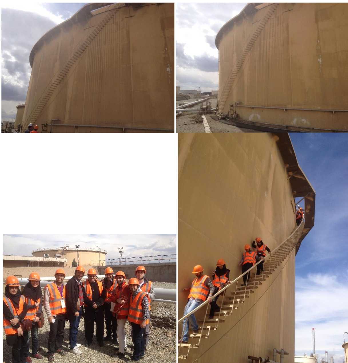
شکل ۱۶- تصویری از مخازن ۳۰۰۰۰ بشکه ای همراه با نردبان دسترسی به سقف از نمای بیرونی، واقع در پالایشگاه نفت تهران
