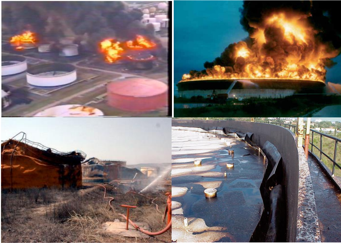
شکل ۸-۱ آتش‌سوزی و آسیب‌های وارده بر مخازن با سقف شناور در زمین‌لرزه‌ی ازمیت ترکیه ۱۹۹۹ [۱۷]
