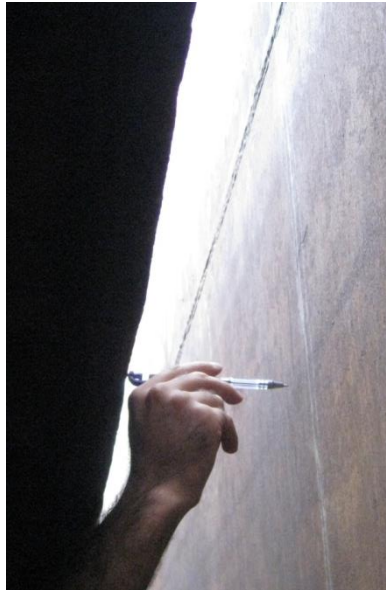
شکل ۱۲-۰ فاصله بین دیواره خارجی سقف مخزن و جدار داخلی مخزن که با Tube seal پر می شود
