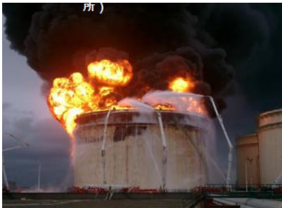
شکل ۱۷- ۱ آتش گرفتن سقف مخزن در اثر پدیده تلاطم در زلزله توکاجی-اوی (۲۰۰۳) [۱۹]
