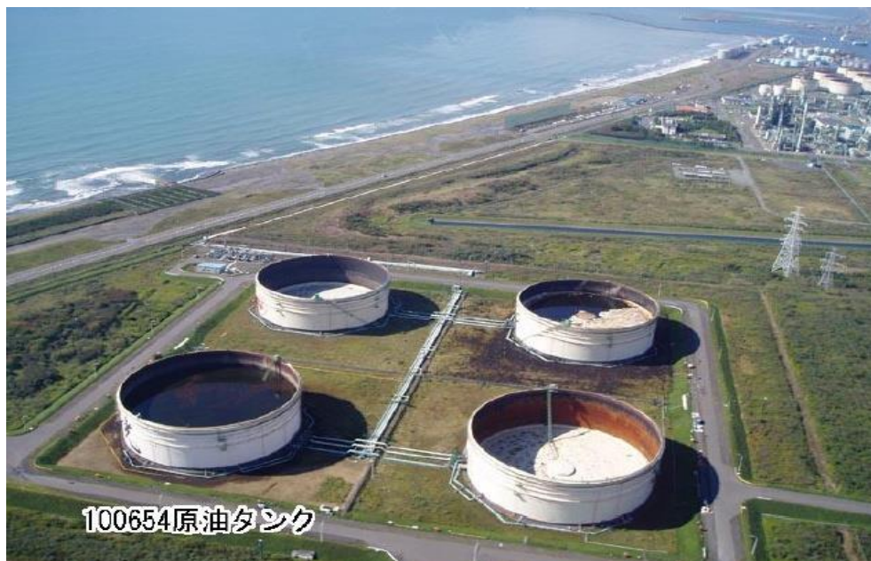
شکل ۱۶- ۱ سقف مخازن نفت خام ۴ روز پس از زلزله به طور کامل غرقاب شدند [۱۹]
