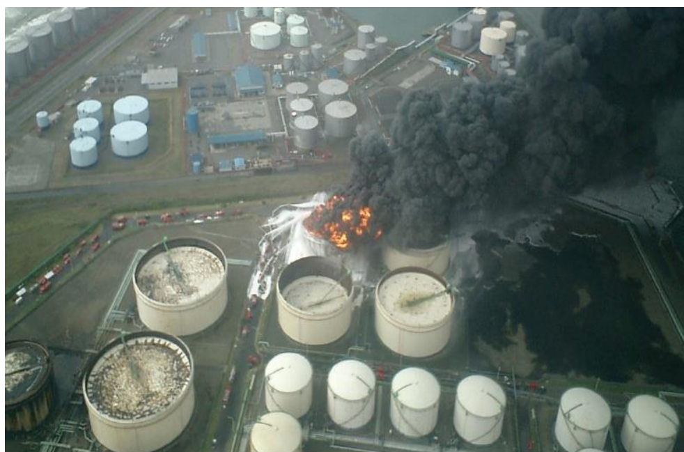
شکل ۱۵-۱ آتش گرفتن مخازن نفت در زلزله توکاچی اکی-ژاپن (۲۰۰۳) [۱۹]
