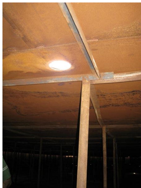
شکل ۱۰-۰ سوراخ های تعبیه شده در سقف جهت گذراندن پایه‌ها LEG
