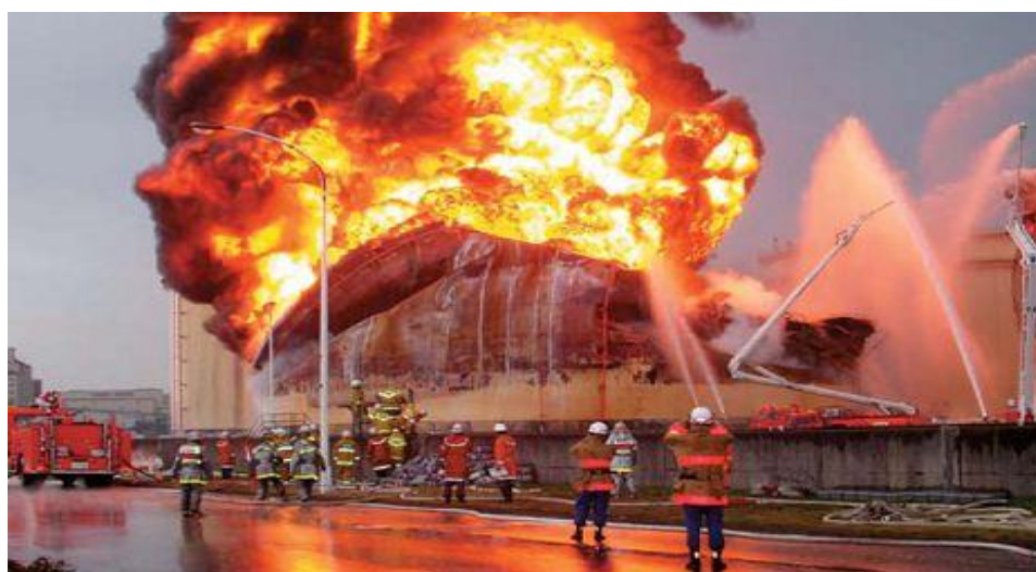
شکل ۱۲-۱۱ مخزن b در حال آتش‌سوزی. (زلزله‌ی توکاشی اوکی ژاپن ۲۰۰۳) [۱۹]
