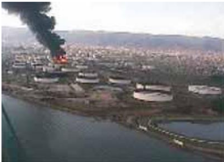
شکل ۱۰-۱ پالایشگاه توپراس، مخازن دارای سقف شناور دچار حریق شدند [۱۷]
