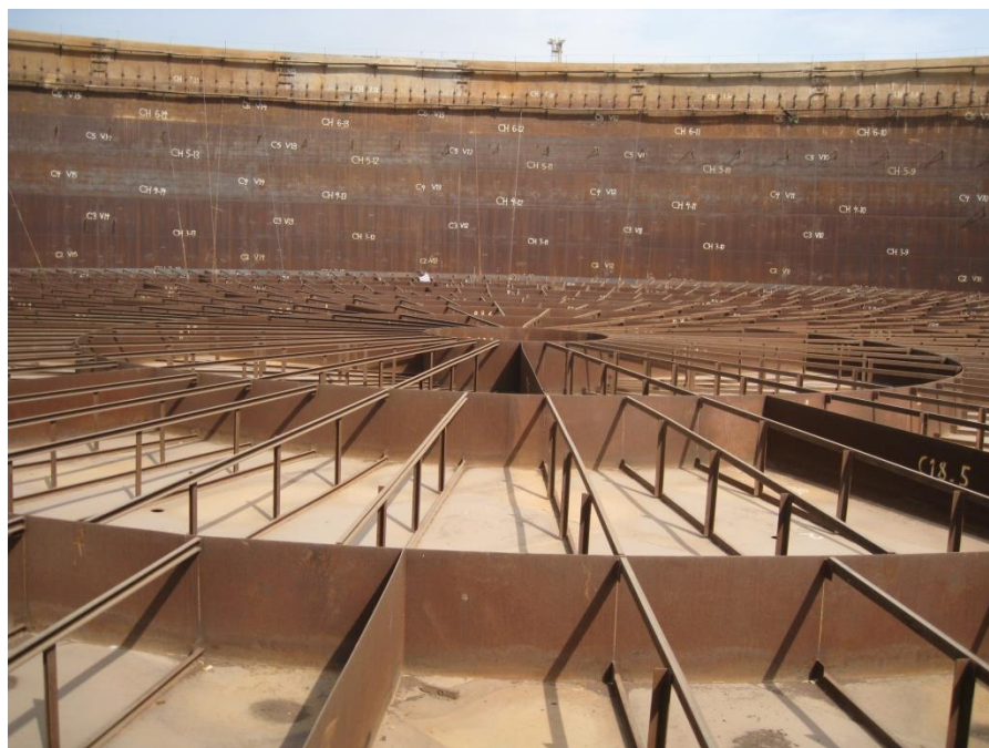
شکل ۲-۰: نمای داخلی از مخزن یک میلیون بشکه‌ای شماره ۳۸ در حال ساخت در بازدید از مخازن با سقف شناور جزیره‌ی خارگ
