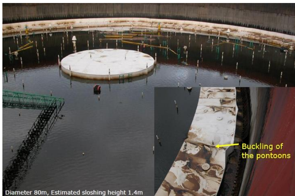
شکل ۱۴-۱ خروج نفت در قسمت‌هایی که دچار کمانش شده‌اند در اثر پدیده تلاطم [۱۹]
