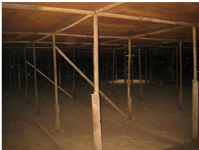
شکل ۸-۰ قرار گرفتن مخزن بر روی پایه هایی به نام درخت (عملیات مرسوم به درختکاری)
